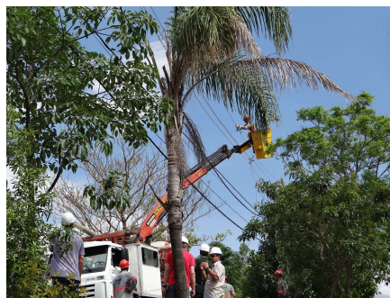
FIGURAS 5 e 6 – Circuitos selecionados para o projeto piloto instalando o cabo coberto dupla camada
