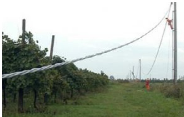
FIGURA 7 – Lançamento de um condutor isolado
