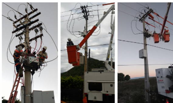
FIGURA 10 – Fotos de Execução dos Equipamentos
