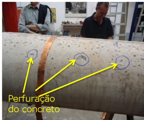
Figura 10 – Danos na base do poste autoaterrado com concreto convencional
