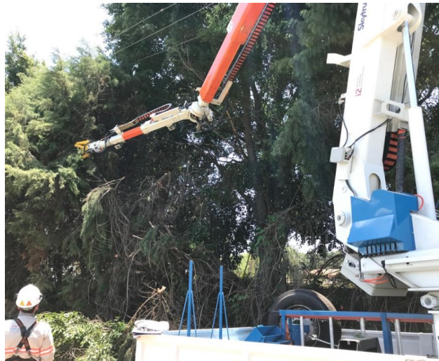
FIGURA 13 – Poda mecanizada realizada próxima à linha desenergizada
