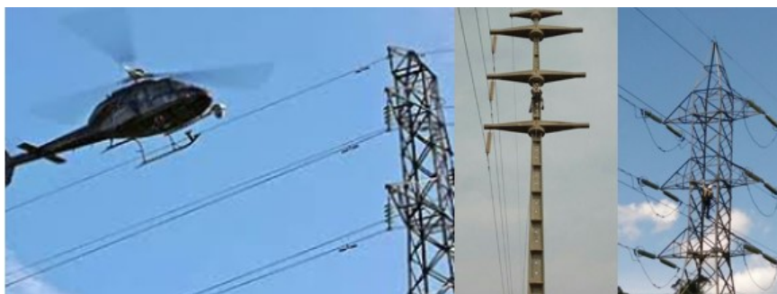
FIGURA 1 – Inspeção aérea com helicóptero e Inspeção detalhada
