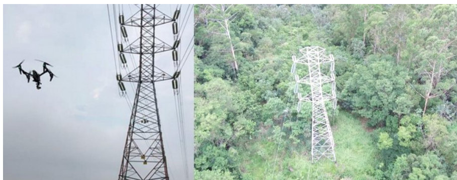
FIGURA 4 – Inspeção com drones e imagem do Drone
