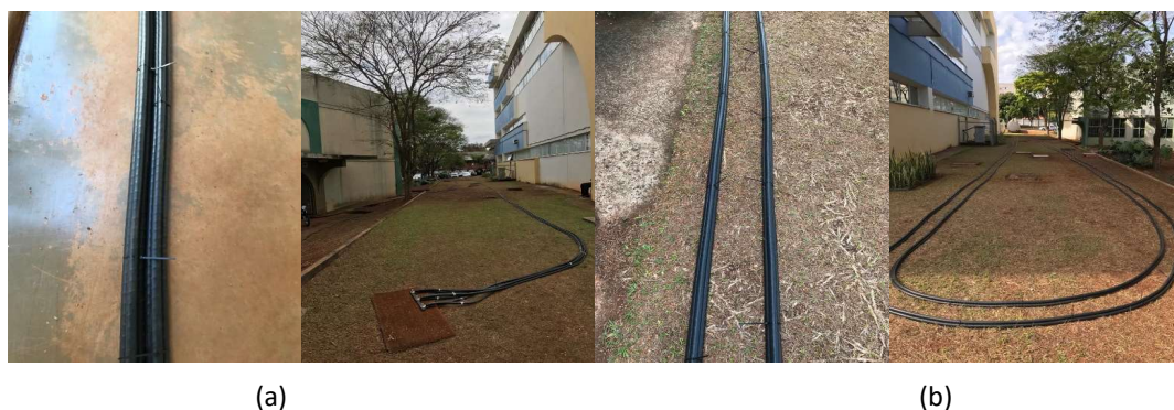
FIGURA 5 – (a) Arranjos na forma de trifólios justapostos esticados sobre o solo. (b) Arranjos na forma de trifólios separados entre si por uma distância de 20 centímetros, esticados sobre o solo.
