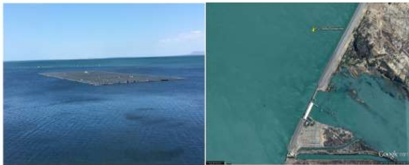
FIGURA 5 - Estágio atual da implantação da usina fotovoltaica flutuante e sua localização (Fonte: Autor / Google Earth)
