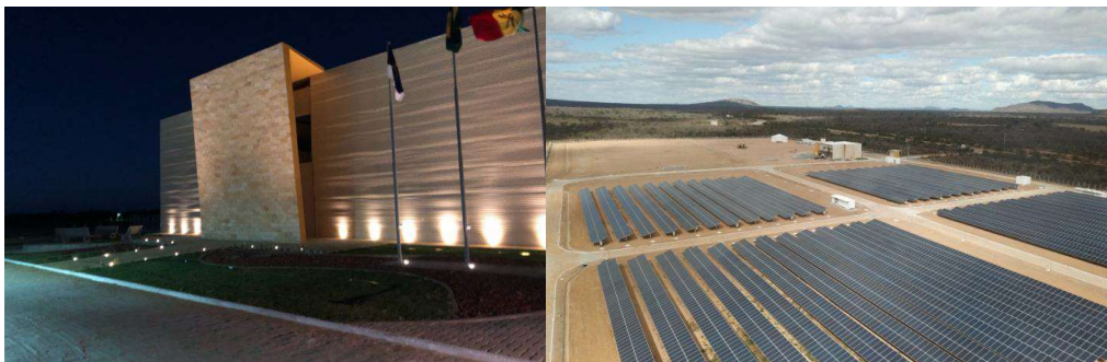
FIGURA 2 – CRESP - Fachada do Edifício Sede e Planta Fotovoltaica Base de 2,5 MWp
