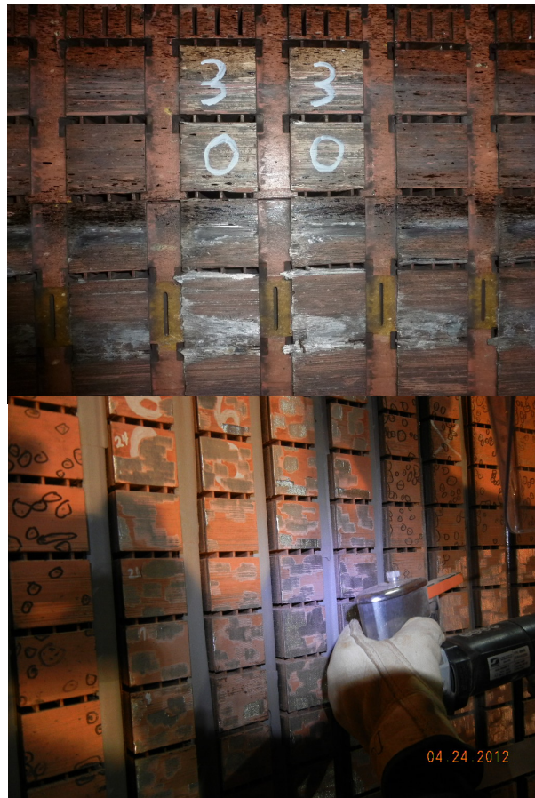
Figura 2 - Núcleo do estator: Inspeção visual e lixamento
