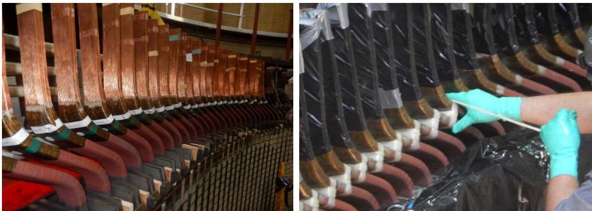
Figura 9 – Instalação do enrolamento do estator
