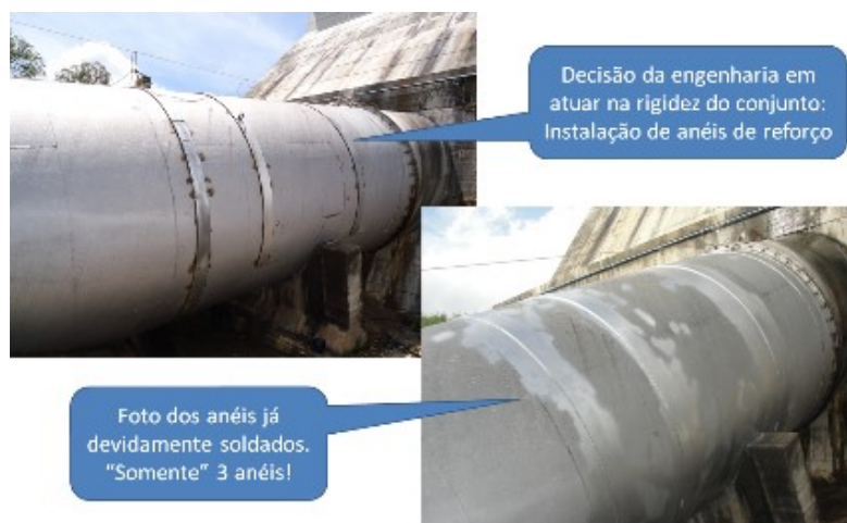
FIGURA 10 – Montagem dos anéis no conduto forçado
