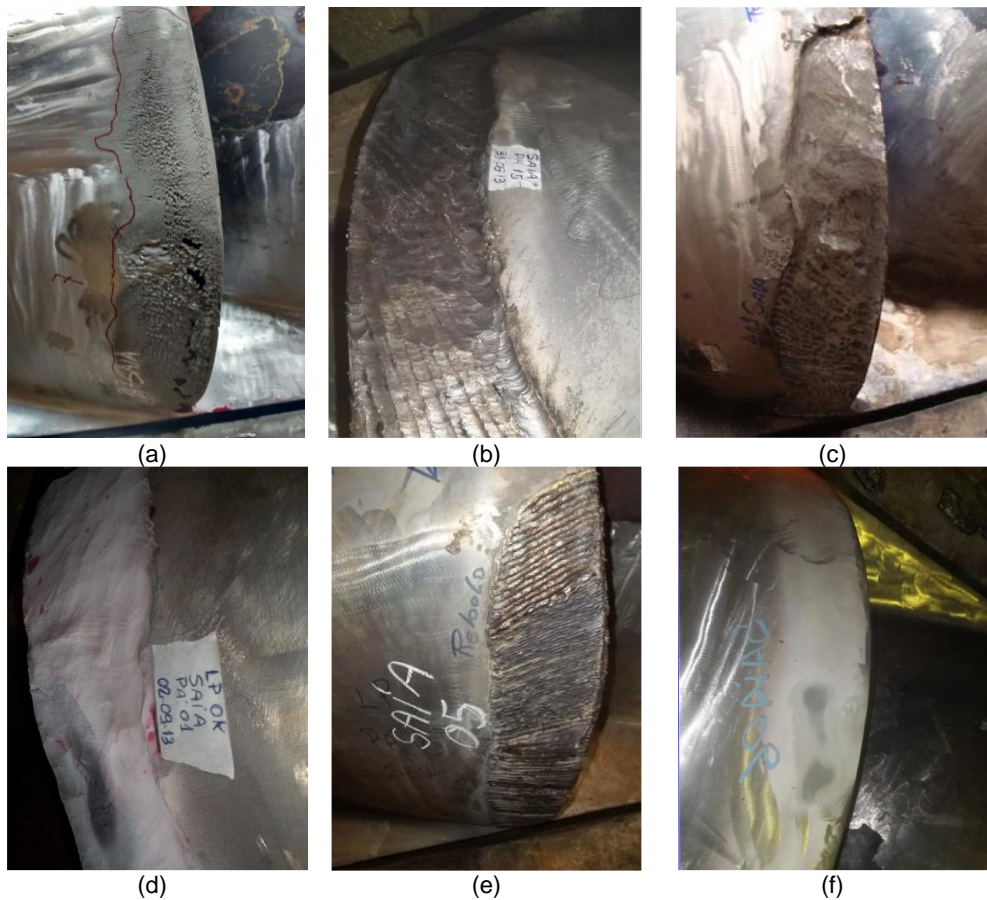
FIGURA 6 – Processo de recuperação das pás do rotor da turbina da UHE GBM. (a) mapeamento das erosões cavitacionais, (b) remoção por goivagem do material danificado, (c) esmerilhamento, (d) ensaio por líquido penetrante, (e) soldagem e (f) recuperação do perfil hidráulico e inspeção final por líquido penetrante.
