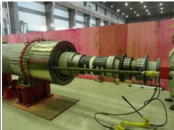
FIGURA 20 – Montagem da capa LNA
