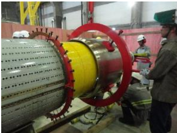
FIGURA 19 – Montagem da capa LA
