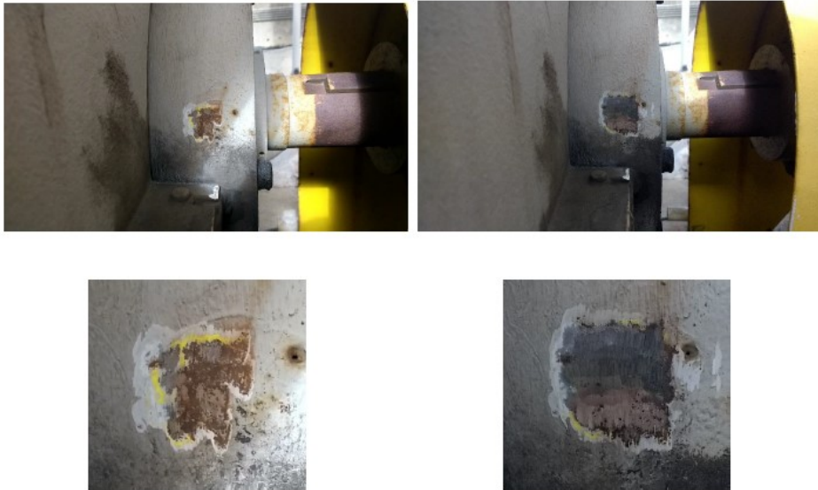
FIGURA 3 – Superfície preparada com utilização de esmirilhadeira manual
