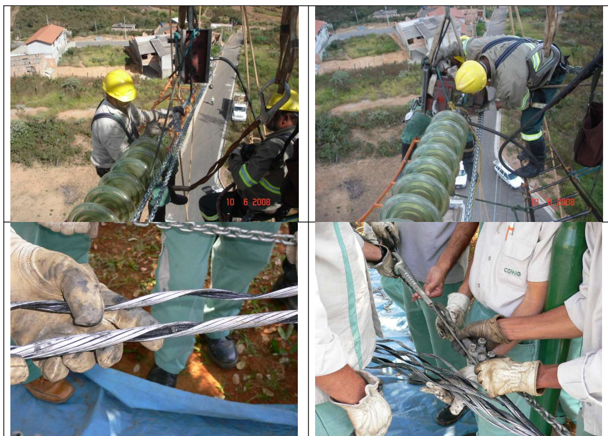
FIGURA 2 – Detalhes da instalação do cabo GZTACSR – Grampeamento
