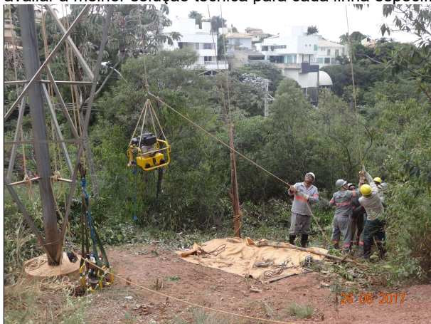
Grampeamento no alto da torre
