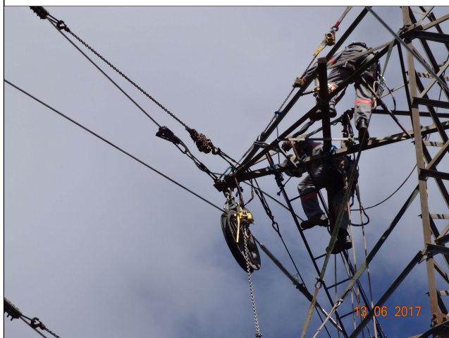
Passagem do cabo já grampeado pela bandola
