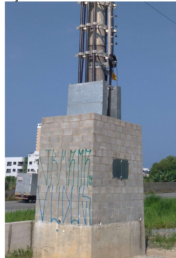
FIGURA 12 – Proteção de Alvenaria (Executado).
