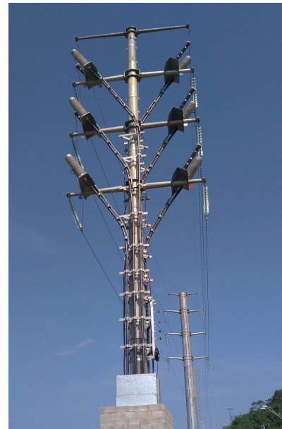
FIGURA 8 – Estrutura de transição (Executada).
