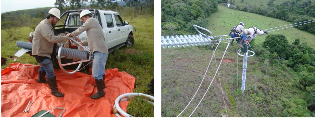
Figura 13 – Montagem do para-raios e Figura 14 – Instalação na estrutura
