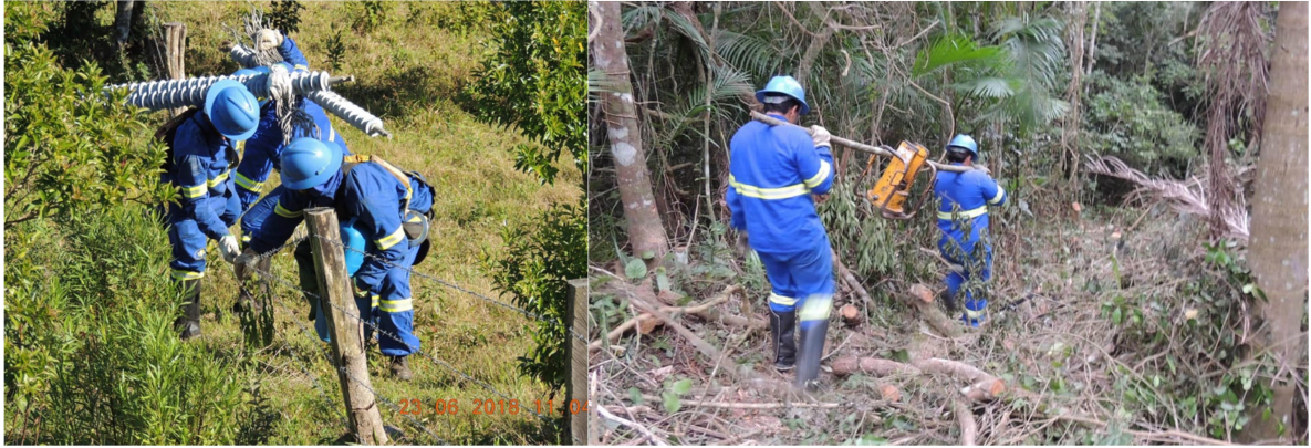
FIGURA 7 – Transporte de materiais e equipamentos a pé até as torres sem acesso de veículos
