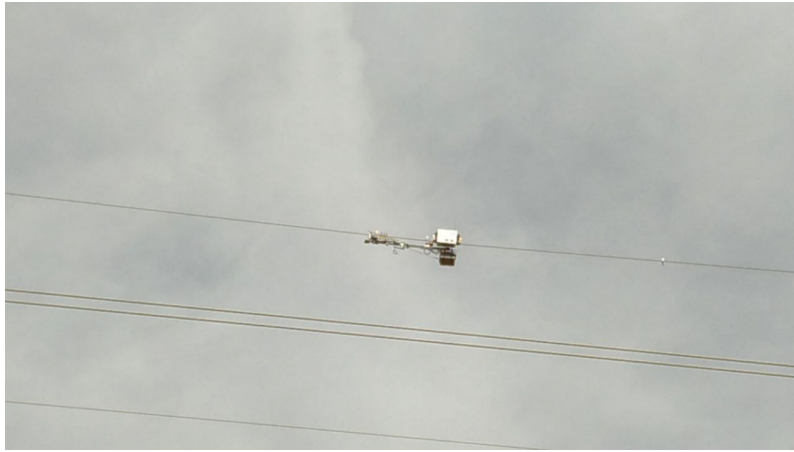
FIGURA 5 – 1º teste realizado em linha energizada 230kv - Porto Primavera - State Grid
