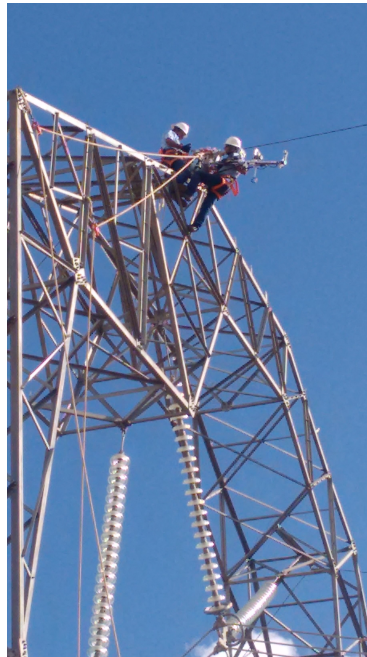
FIGURA 2 – 1º teste realizado em linha desenergizada – Pires do Rio – GO (Centro de treinamento da State Grid)
