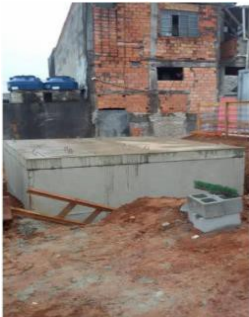
Figura 7 – Instalação da caixa separadora de água e óleo.
