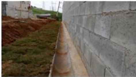
Figura 10 – Execução do sistema de drenagem.
