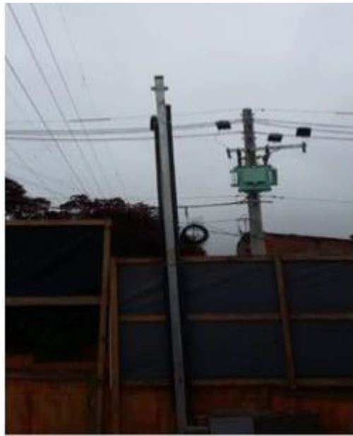
Figura 8 – Montagem da parede corta fogo.
