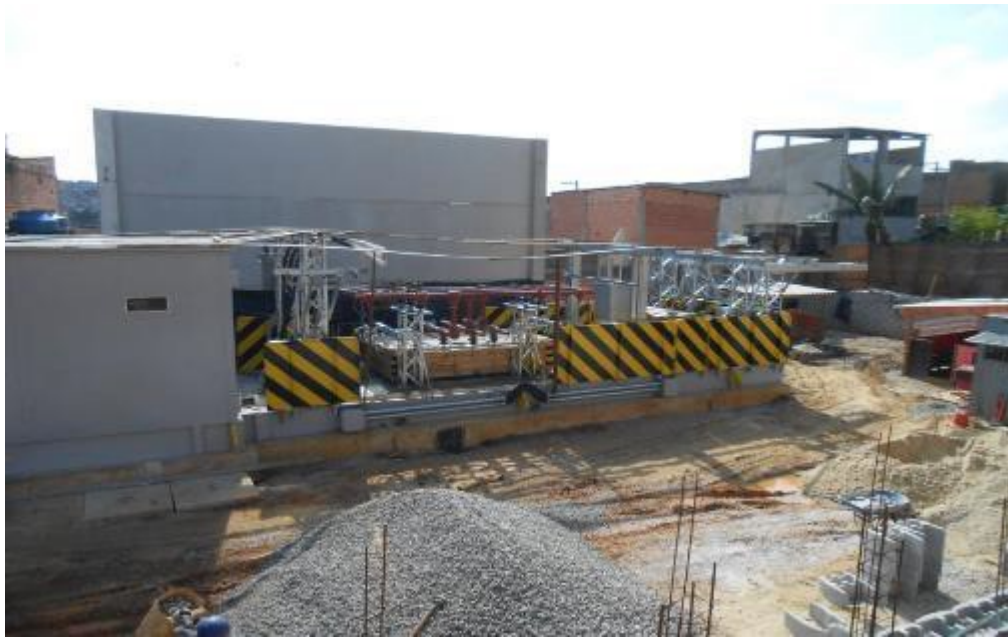
Figura 6 – Montagem da plataforma skid na base civil.
