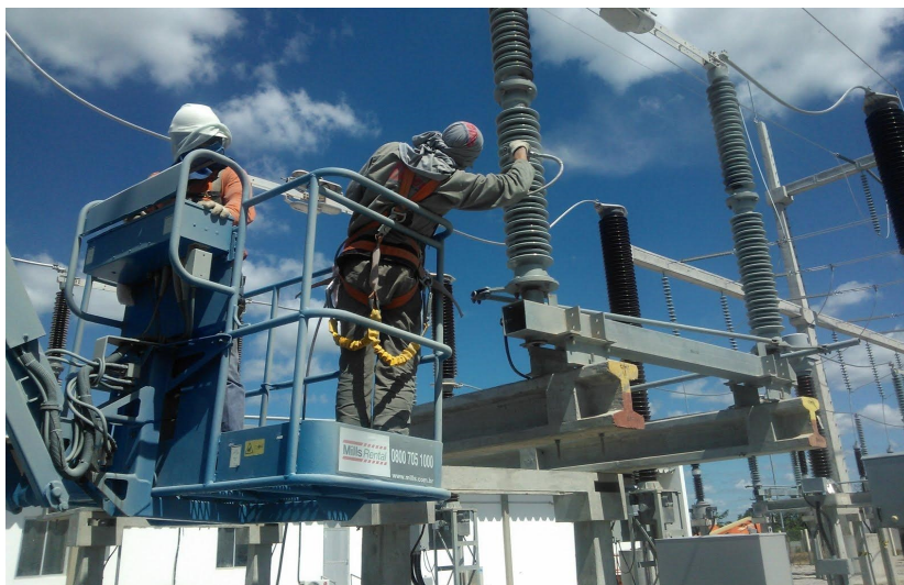
FIGURA 2 – Aplicação de revestimento RTV na superfície de um isolador em uma subestação
