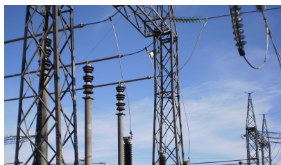
FIGURA 6 - CEMIG – Inspeção termográfica em para-raios de 138 kV
