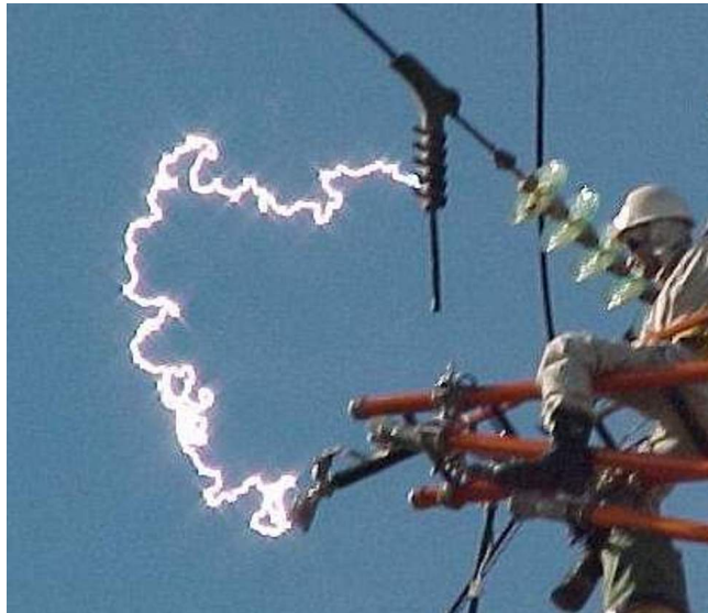
FIGURA 3 – Abertura de trecho de 6 Km de linha de transmissão de 230 kV da CEEE-GT
