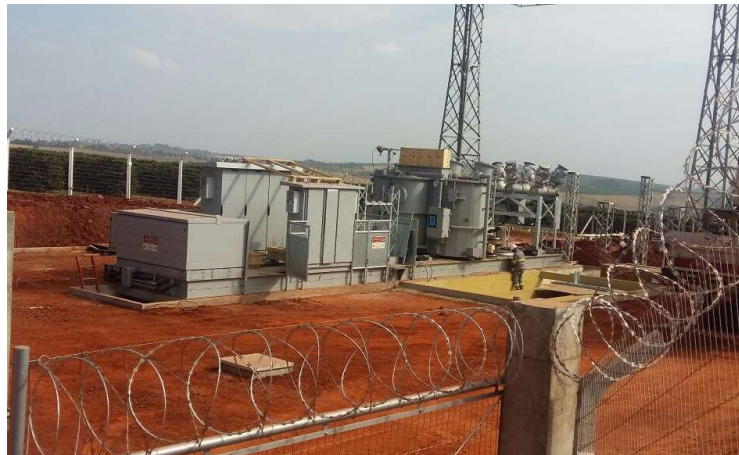
Fotografia 1 – Chassi da SECI com equipamentos – Colocação sobre a base da fundação.
