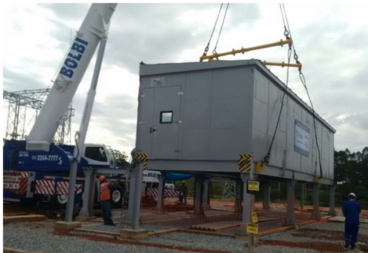
FIGURA 4 – Descarregamento do módulo do MIMC-MT SE São Sebastião do Oeste (Fonte: CEMIG)
