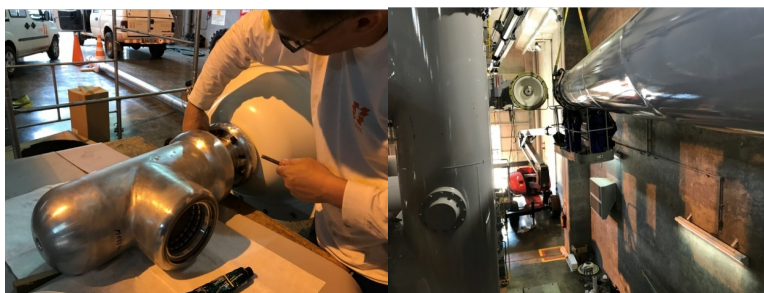
Figura 10 - Montagem da barra A
