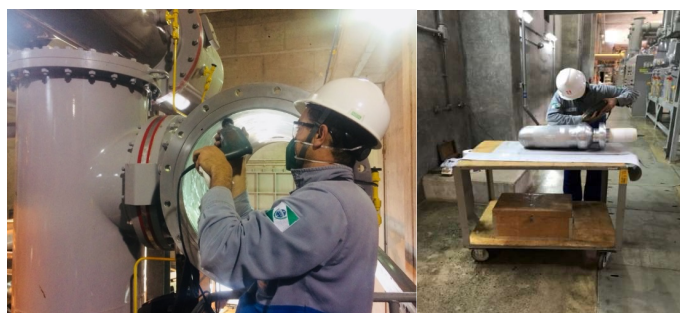
Figura 9 - Retífica e polimento da barra e do invólucro
