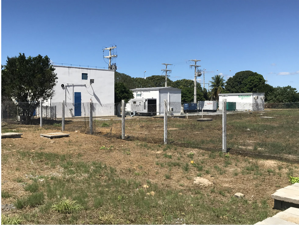
FIGURA 2 – Edificações e Serviços auxiliares para acessantes - SE Bom Jesus da Lapa
