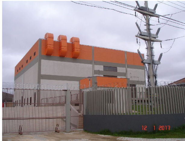
Figura 04 - Fachada da subestação Copel Hauer 138kV
