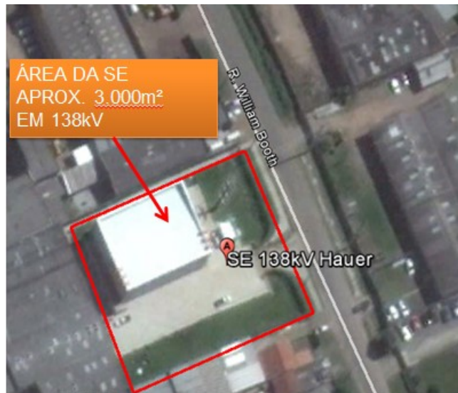
Figura 02 – Subestação Copel Hauer 138kV
