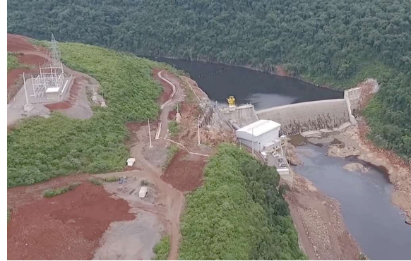
Figura 2 – Montagem da subestação com o transformador próximo a área de serviço e com a subestação afastada da casa de força
