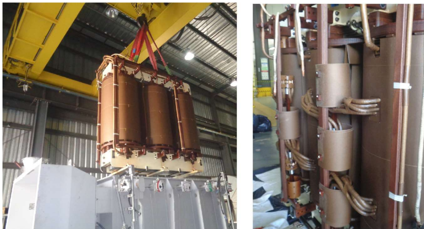
Figura 3 – Retirada da parte ativa e comutador enclausurado.
