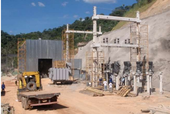
Figura 2 – Montagem da subestação com o transformador próximo a área de serviço e com a subestação afastada da casa de força
